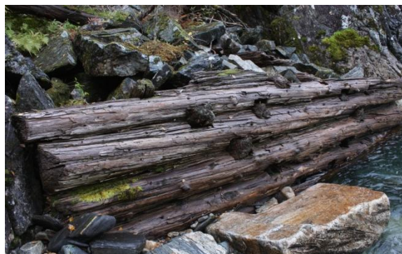
Skådam, i Kappscardelva i Grane, for å hindre at tømmeret satte seg fast.
