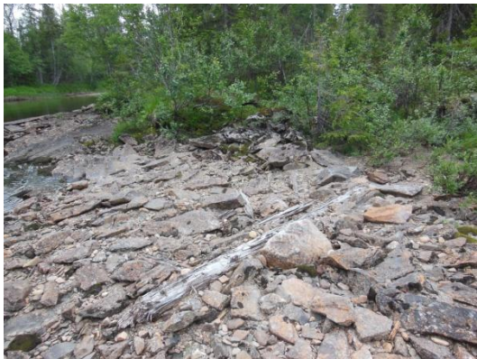
Dammen på Langskardneset i Vefsn er eksempel på dam der det knapt er synlige rester.
