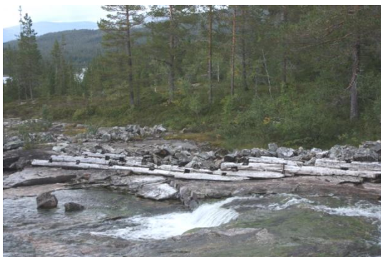
Skådam, i Kjerringvasselva i Grane, for å hindre at tømmeret havnet innover land når det ble mye vann i elv.
